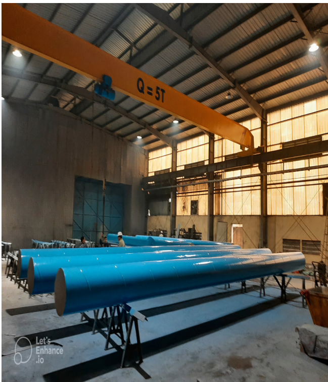
Dự án đường ống nước sạch Clean water supply pipe project
