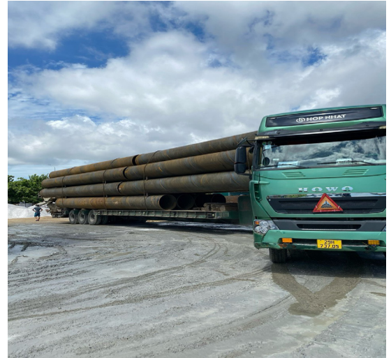
Dự án cầu Nhật Lệ 3 - Quảng Bình Steel pipe pile of Nhat Le 3 overpass project
